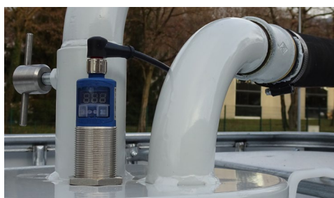
G. Sicurezza Indicatore elettrico di livello con stop automatico quando la vasca è piena.
